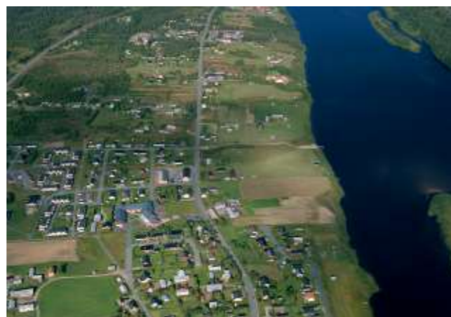
Centralorten har idag en gles bebyggelsestruktur och goda möjligheter till förtätning finns. Foto: Pajala kommun.
