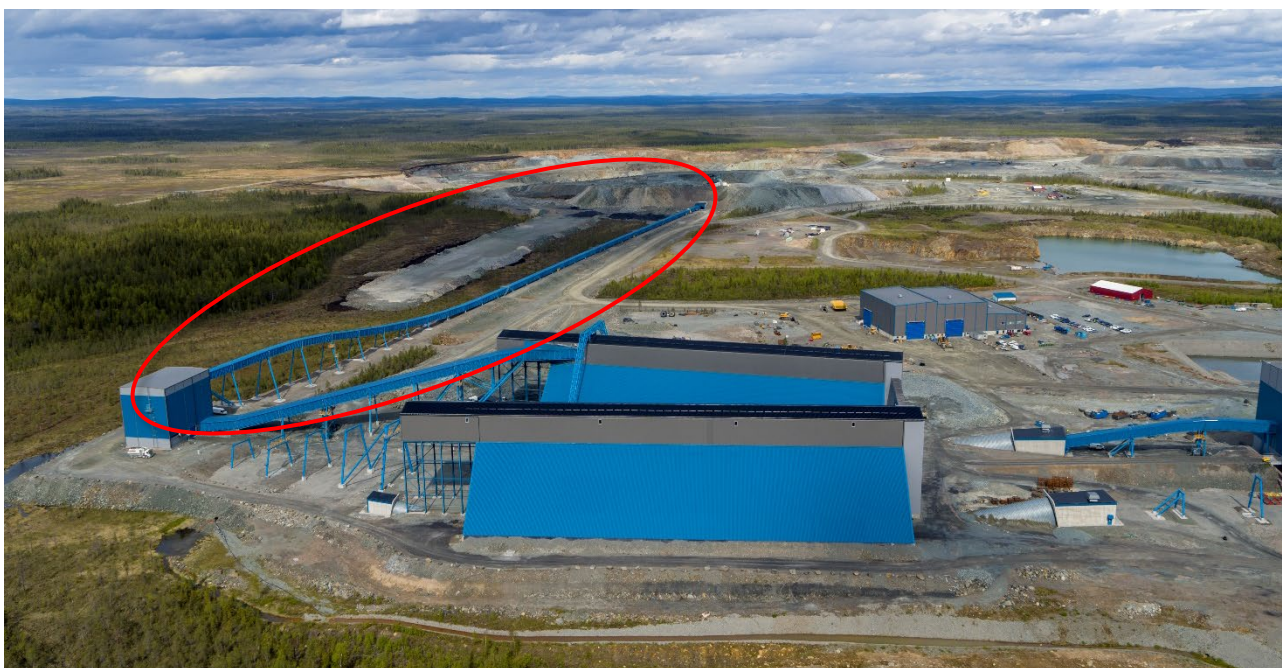
Figur 22. Bilden visar en möjlig utformning av transportband mellan gruvan (i bakgrunden) och anrikningsverket (i förgrunden). Transportbandet är markerat i rött. Mindre teknikbyggnader kan behövas för att möjliggöra svängningar i transportörens dragning.
