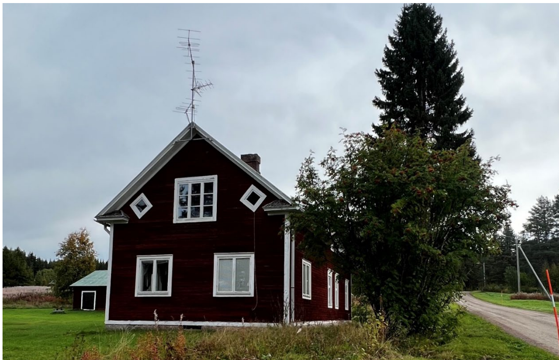
Figur 18. Fotot visar en gammal gårdsmiljö. Intentionerna är att flytta byggnaden i bild till ett nytt läge för att bevara denna.
