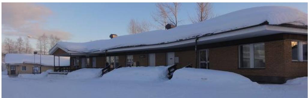
Fastighet Junosuando 5:18 sett från Strandvägen, i bakgrunden skymtar fastighet Junosuando 5:41.
