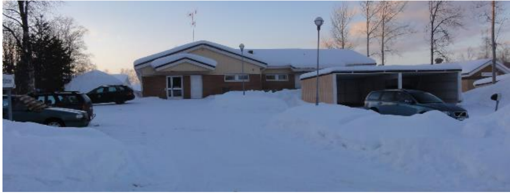
Fastighet Salmijärvi 1:10 sett från Lautakoskivägen.
