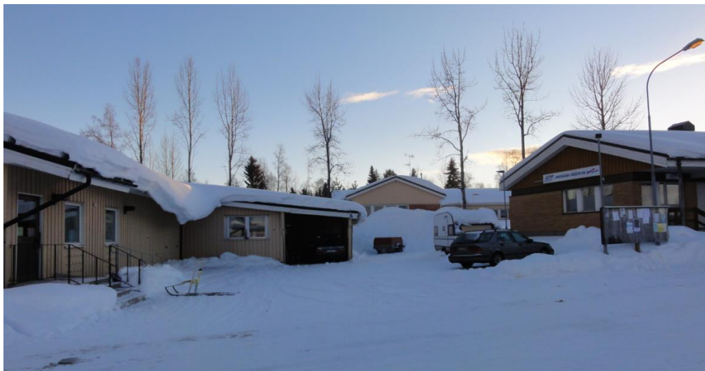
Till vänster i bild syns fastighet Junosuando 5:41 till höger, fastighet Junosuando 5:18, i bakgrunden syns fastighet Salmijärvi 1:10, sett från Strandvägen.
