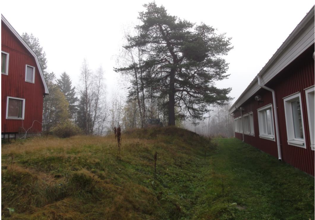
Nivåskillnad mellan den gamla lärarbostaden till vänster i bild och skolbyggnaden till höger i bild, fotograferat från väster.
