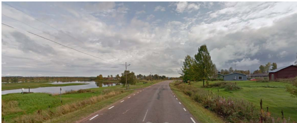
Väg 395 är en barriär mellan bebyggelsen och Torne älv. Bilden visar vägens utseende innan de trafiksäkerhetshöjande åtgärderna. Källa: Google Maps
